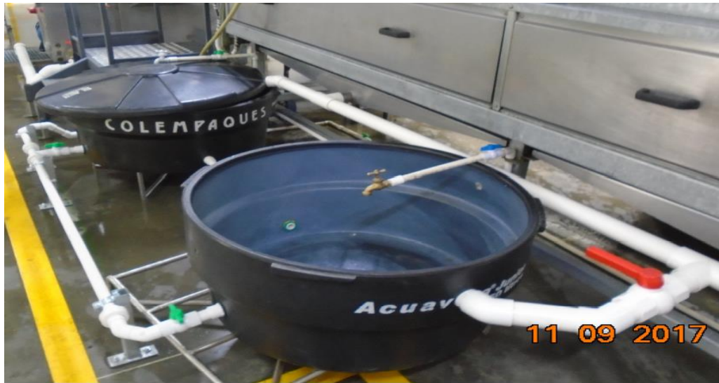
Figura 11. Cambio de la instalación del sistema de alimentación de los aspersores.
