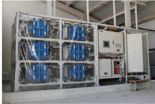
Fig 22. Batería redox Vanadio
